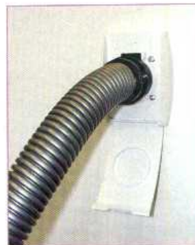
Der Schlauch wird in die Saugdose gesteckt und das Saugen kann beginnen.
